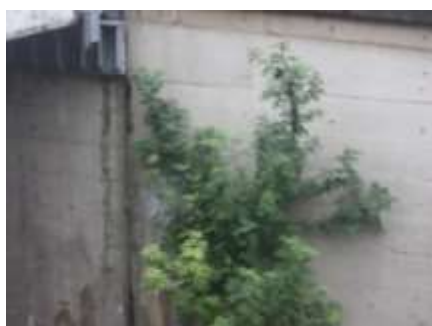
A 谷中橋、2019,7,2 の状態
