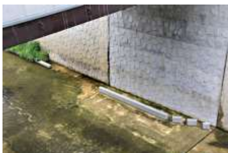
（本村橋架替後のコンクリート河床）
