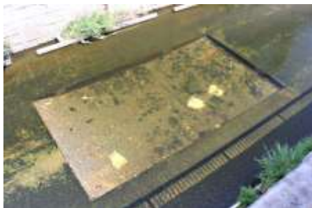
（河床の湧水孔・八幡橋付近）
