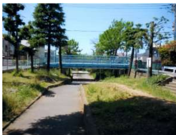
呑川緑道（旧呑川）に残る呑川橋（下流側より）
