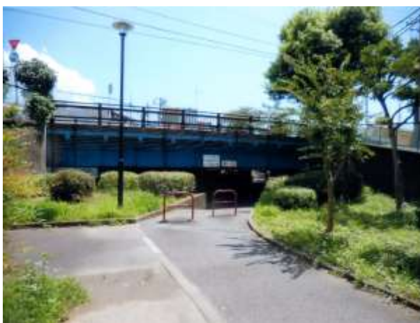
呑川緑道（旧呑川）に残る川下橋（上流側より）
