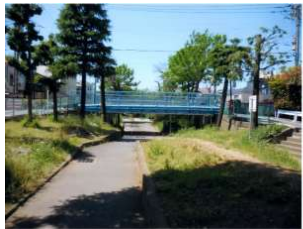
呑川緑道（旧呑川）に残る呑川橋（下流側より）
