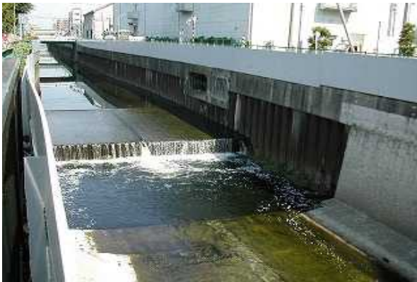
写真は 道々橋下流の下水道横断地点 落差工 約50cm
