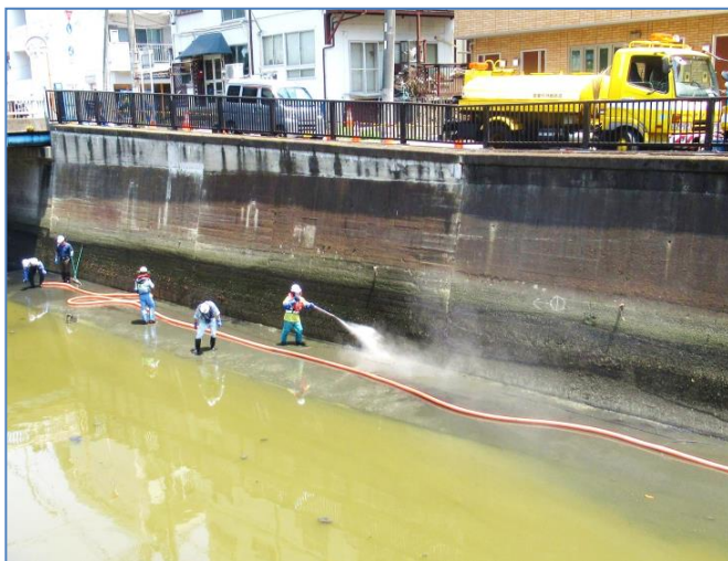
写真1: 護岸部のジェット洗浄(左岸側)
