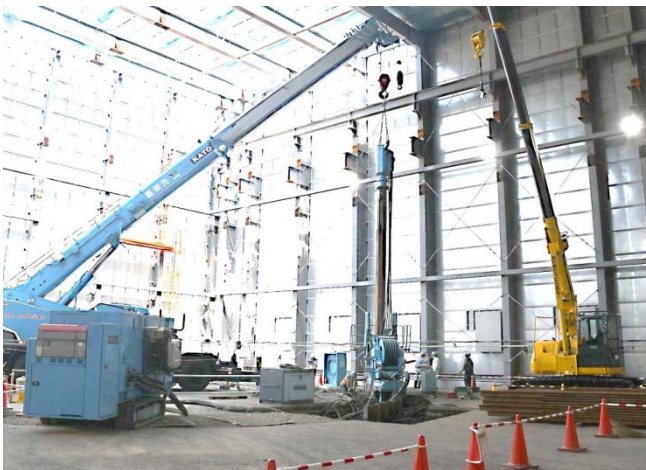
土留工事風景(鋼矢板打込み作業開始段階)
