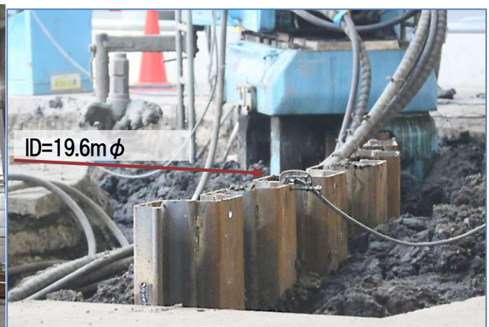
土留用鋼矢板(深さ9m x 154枚)の打込み
