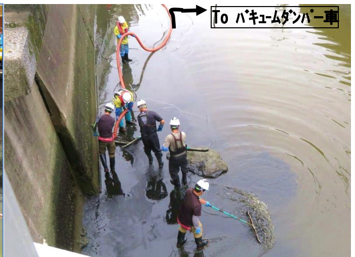
写真2: 犬走り部堆積汚泥の吸引回収(右岸側)
